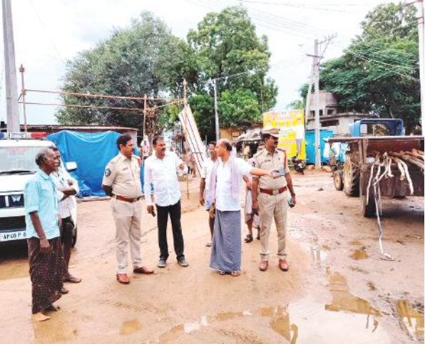
గ్రామంలో 31 లక్షల రూపాయలతో నిర్మించిన సిమెంటు రోడ్
